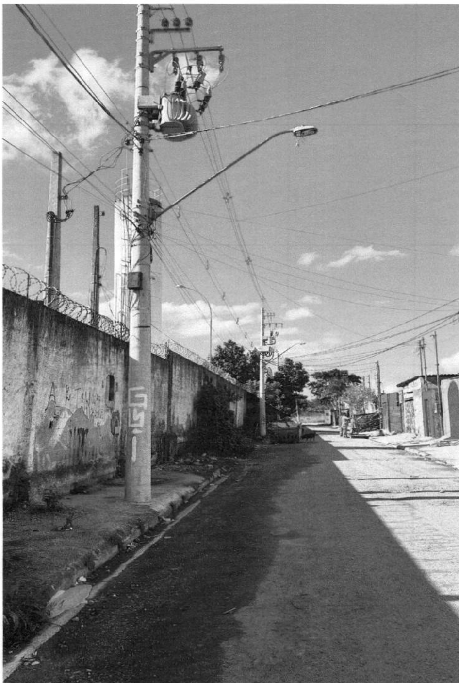
IMPLANTAÇÃO DE LÂMPADA NO POSTE DA RUA PROJETADA EM FRENTE AO N°31, VILA ESTAÇÃO – MOGI DAS CRUZES.
